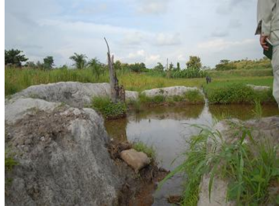
図 3.2.8 壊れたため池
