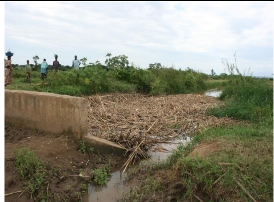
写真6. ドホ灌漑地区の灌漑施設の様子。管理不十分なため、水路にシルトや流木が大量に蓄積し、十分な機能を果たさなくなっている。
