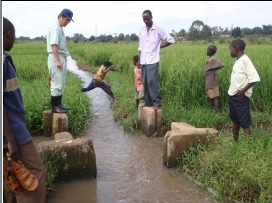
写真5. 東部地域ブガリ灌漑地区の分水口の様子。用排兼用水路として利用している。
