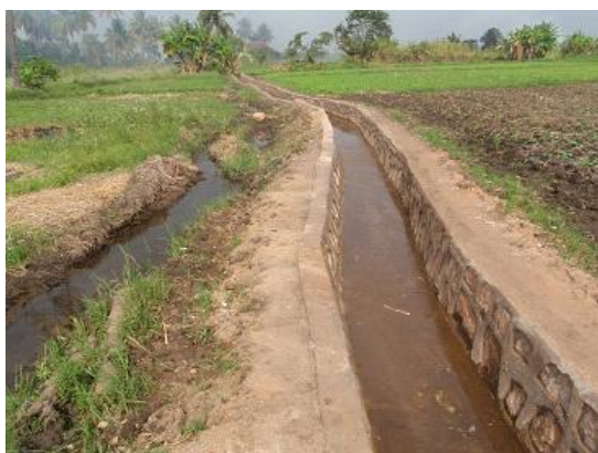
図 2.3.6 古い水路（左）と 2 週間前に新設された水路（右）
