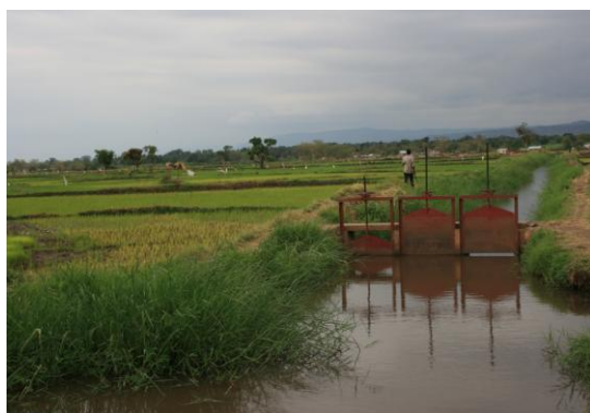
図 2.3.10 整備された水路を持つマ ハンデ灌漑水田
