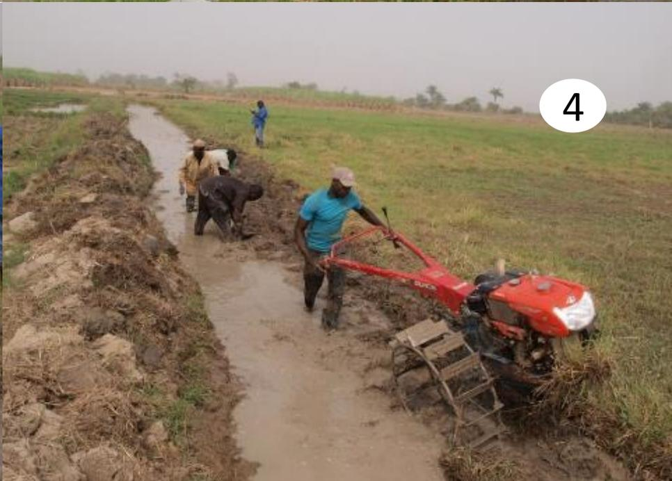
図15. アフリカ水田農法 Sawah Technologyは耕耘機のような適正規模の農業機械を農民の人力と組み合わせてブルドーザーやバックホー等の重機を使わなくても水田開発ができる技術でもある。耕耘機は通常の水田稲作にも使用する。
